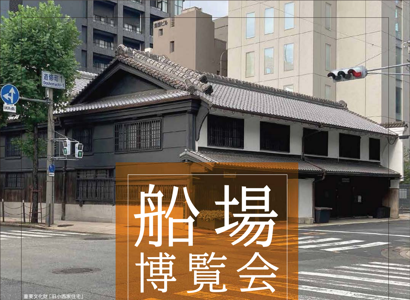
重要文化財「旧小西家住宅」
